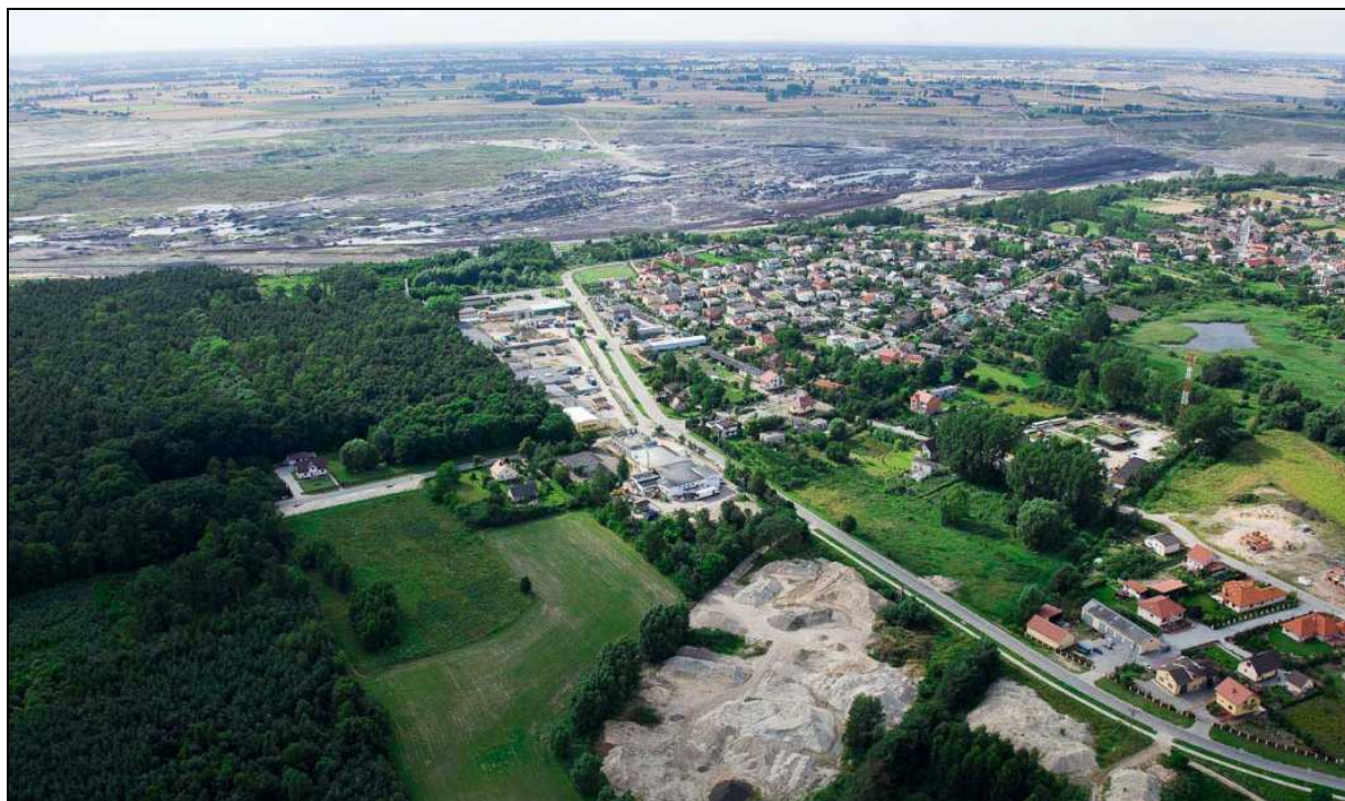
Zdjęcie. Zdegradowany obszar poprzemysłowy w miejscowości Słaboludź (obszar rewitalizacji nr 5), Źródło: Urząd Gminy i Miasta Kleczew
