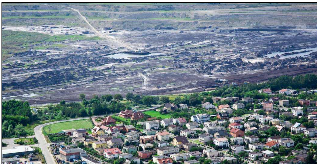
Zdjęcie. Zdegradowany obszar poprzemysłowy w miejscowości Słaboludź (obszar rewitalizacji nr 5), Źródło: Urząd Gminy i Miasta Kleczew
