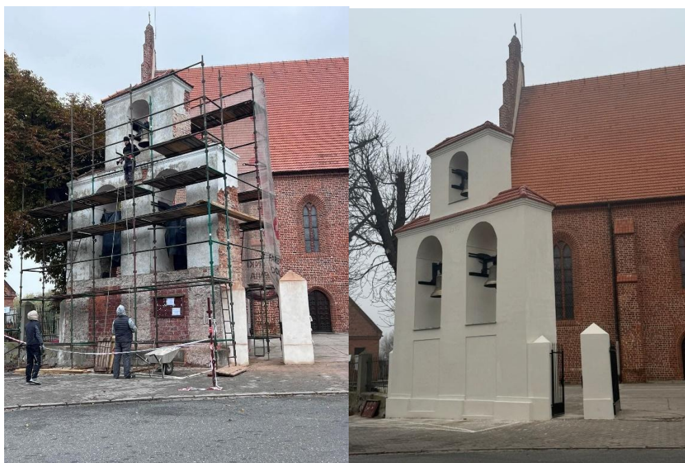
Fotografia 12. Remont elewacji dzwonnicy (przed i po) Źródło: profil Facebook Gminy Kleczew
